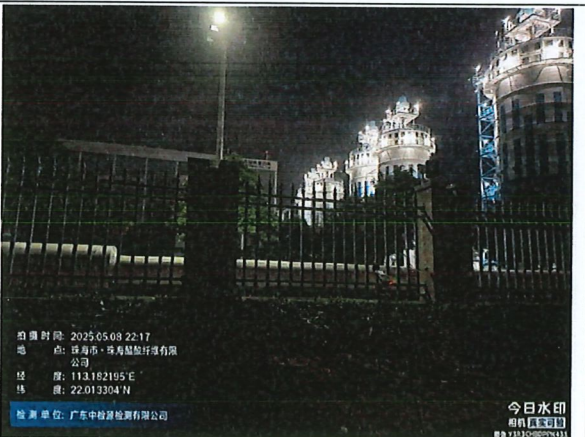
厂界东南外一米（夜间）
