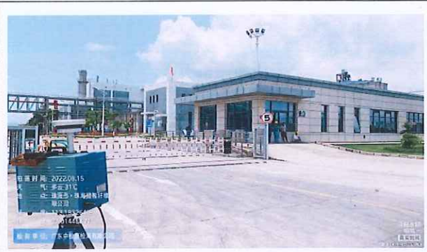
无组织废气下风向监控点 4#
