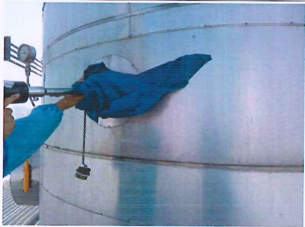
5#废气排放口 (FQ-571-6)
