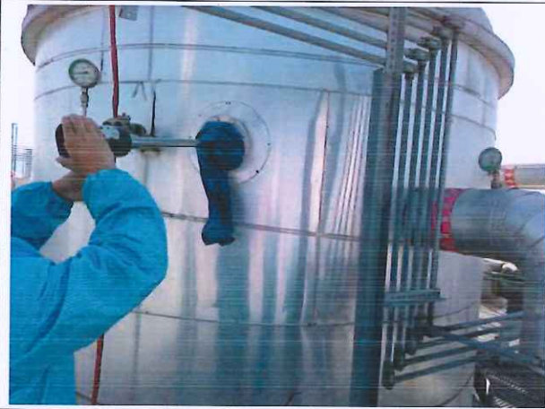
3#废气排放口 (FQ-571-4)
