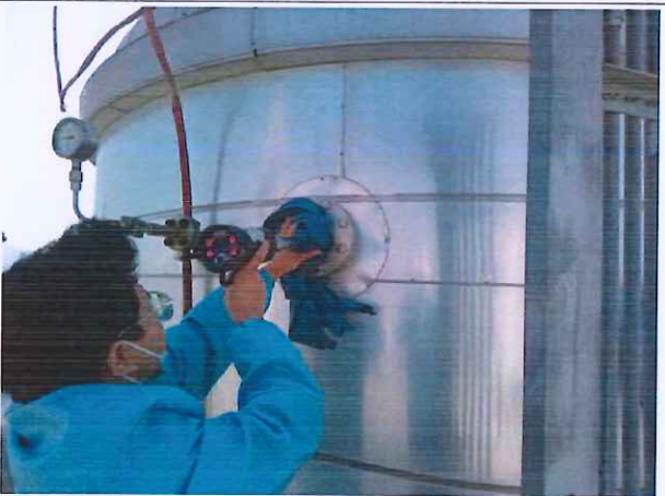
7#废气排放口 (FQ-571-8)
