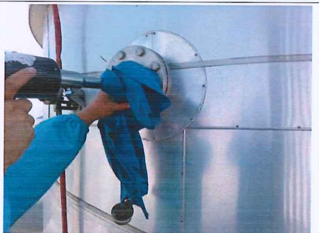
6#废气排放口 (FQ-571-7)
