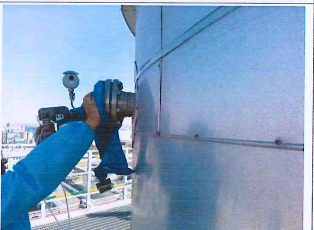
8#废气排放口 (FQ-571-9)
