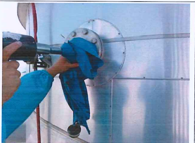
6#废气排放口 (FQ-571-7)
