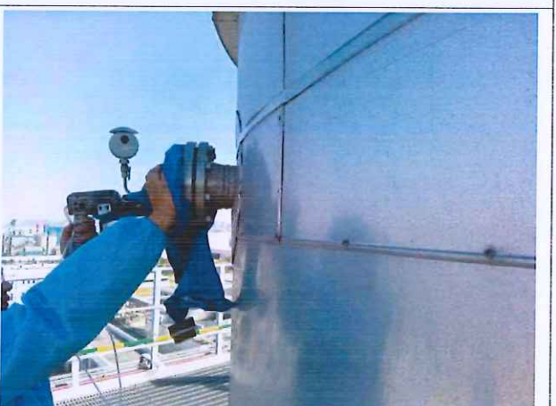
8#废气排放口 (FQ-571-9)
