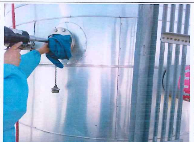
4#废气排放口 (FQ-571-5)
